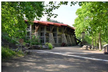
Le bâtiment de la boutique de souvenirs de l'Ocoee Whitewater Center au Tennessee en 2021. Le bâtiment a été détruit par un incendie en avril 2022.
